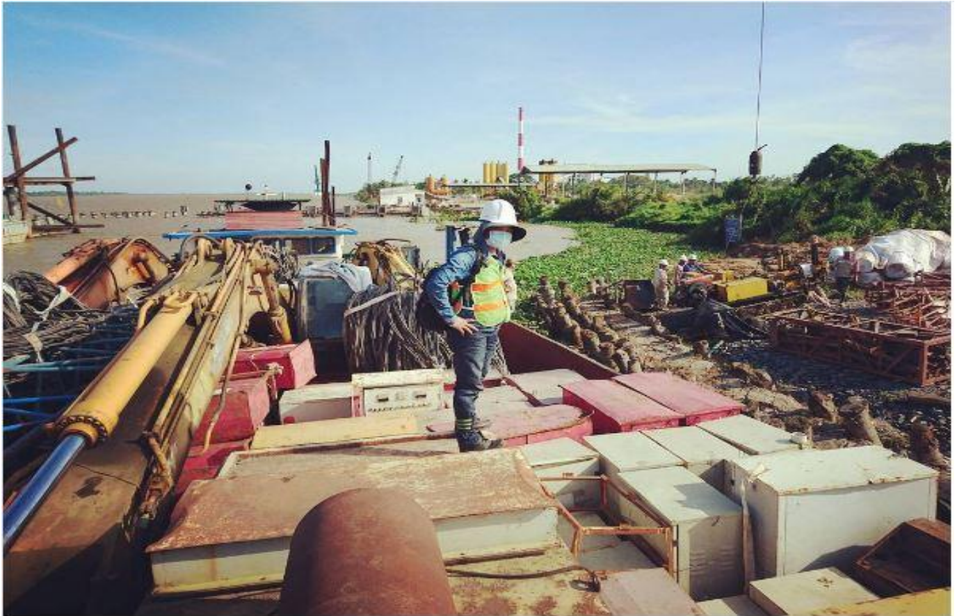
Arbeiten im Rahmen des Kohlekraftwerks Song Hau 1 im Mekong Delta, Quelle: Chành Xe Phú Quốc
